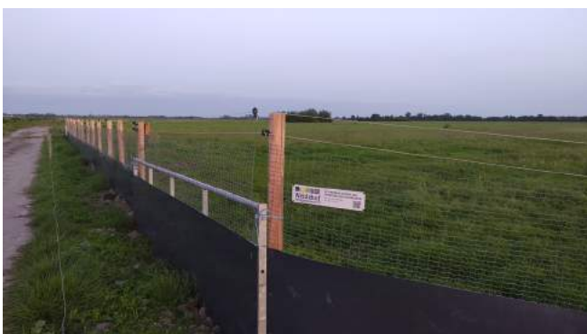
Boven: vossenraster in de Bovenkerkerpolder
