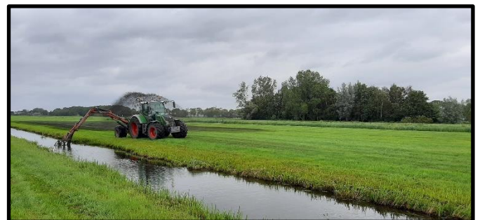
Ecologisch baggeren met de baggerpomp
